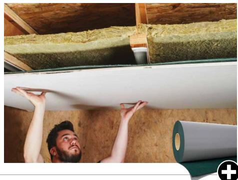
Cerrar la parte inferior del forjado aplicando a las viguetas una capa resiliente de **PIANO A**, **SILENT UNDERFLOOR**, **GEMINI**, **GIPS BAND** o **CONSTRUCTION SEALING** y añadiendo masa a la placa de cartón yeso con **SILENT WALL BYTUM** o **SILENT WALL BYTUM SA**
